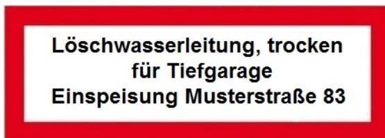
Abb. 3: Beispiel für den Hinweis auf eine Löschwasserleitung im Bereich der Rampe
